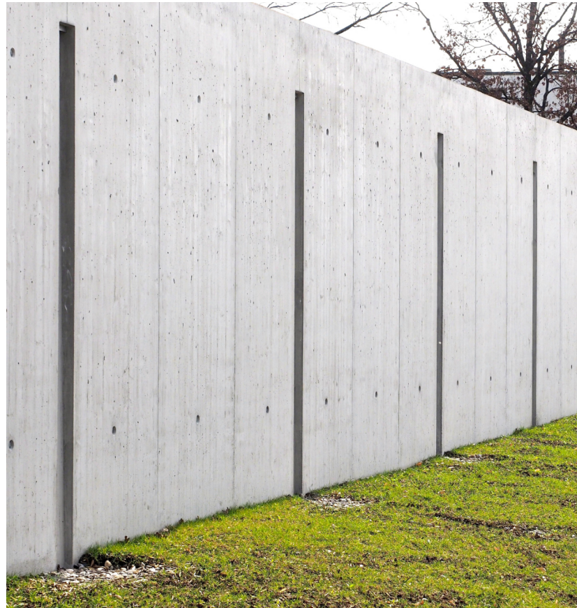
Garagenkubus mit sichtbarer Dachentwässerung
